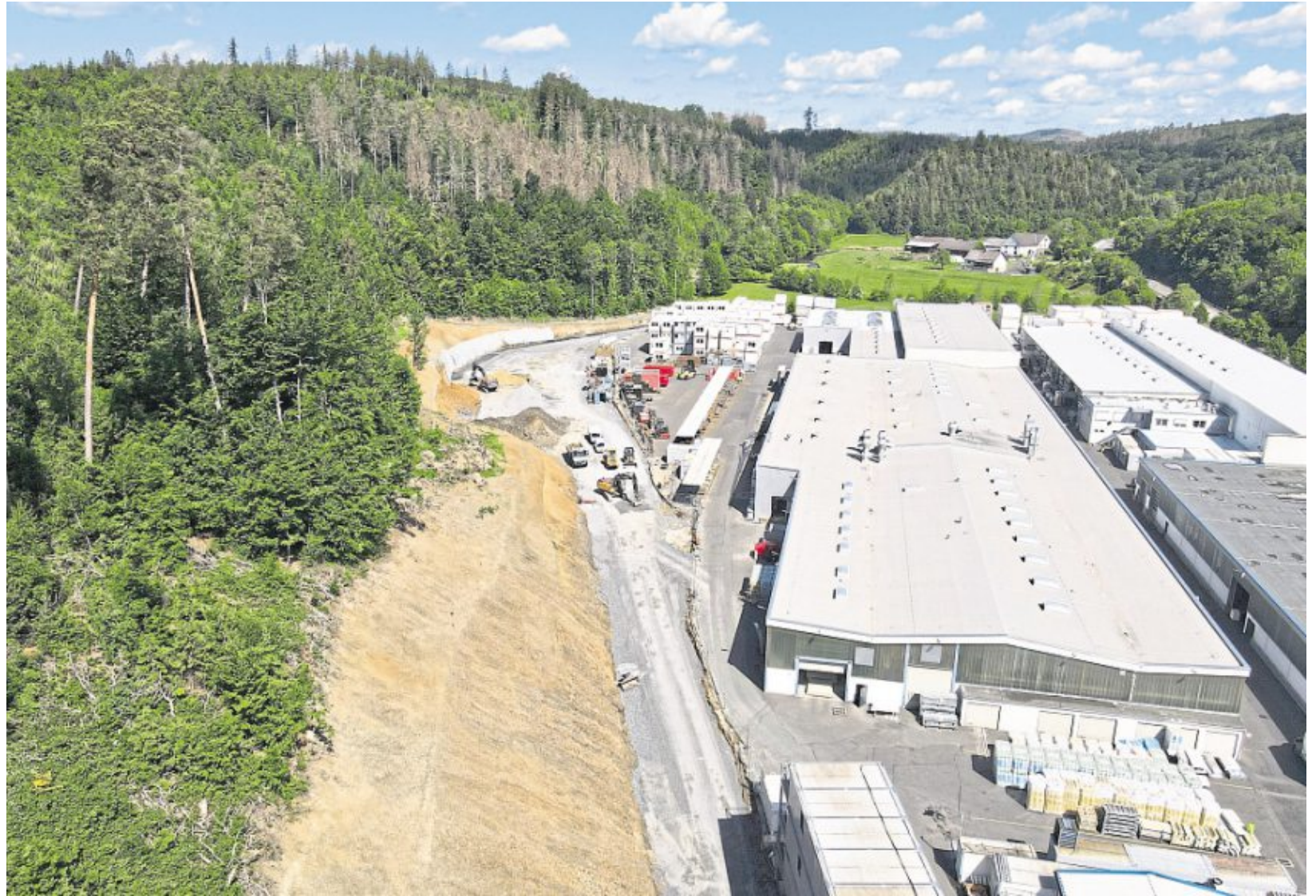
Diese Drohnaufnahme zeigt recht imposant die Dimension der Erdarbeiten, mit denen die Firma Kleusberg derzeit ihre Lagerkapazität enorm erweitert. Auf der neuen Fläche sollen künftig jene Container (hinten) lagern, die frisch aus der Produktion kommen.
